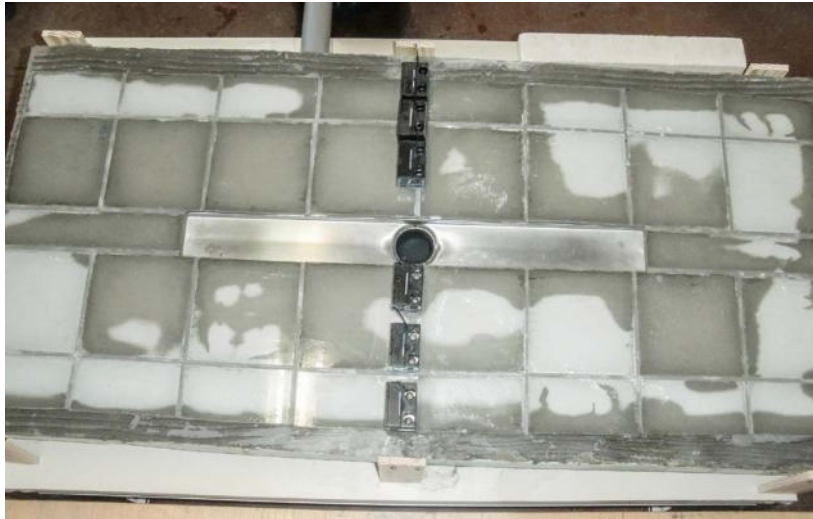
Abbildung 6: Ein Blick durch die Fliesen nach Ende der „Flutung“, zu Beginn der Trocknung: Deutlich sichtbar ist das eingedrungene Wasser im Fliesenmörtel, das sich diffus und willkürlich verteilt hat.
