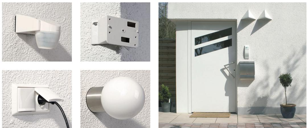
Bild 50: Sichere Befestigung von Ein- und Anbaugeräten mittels Mini-Geräteträger oder entsprechender Gerätdosen
