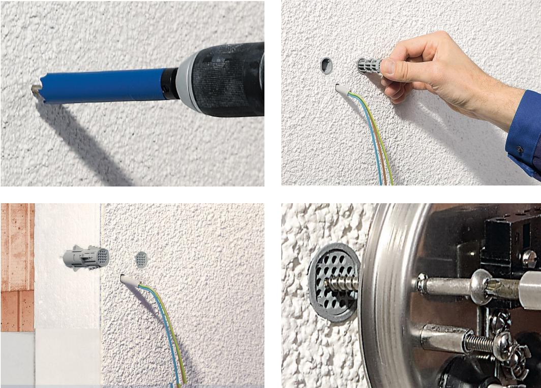
Bild 51: Mini-Geräteträger für den Einbau in Dämmstoffen aus expandiertem Polystyrol, Schaumglas oder mitteldichten Holzfaserdämmstoffplatten
