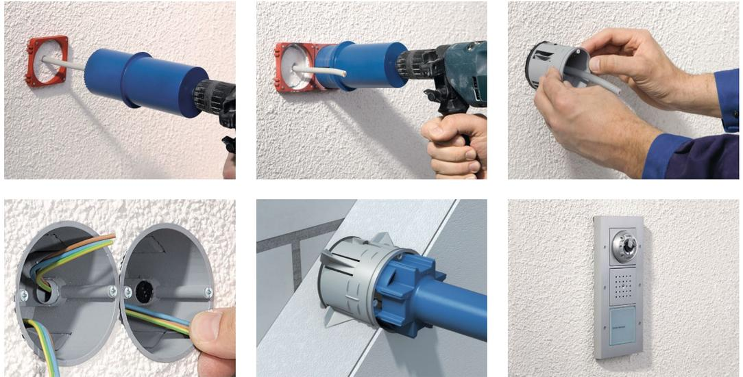
Bild 52: Geräte-Verbindungsboxen für die nachträgliche Installation in Dämmstoffen aus expandiertem Polystyrol oder Schaumglas
