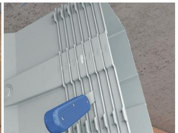
Bild 47: Einbau von LED-Leuchten in gedämmten Fassaden
