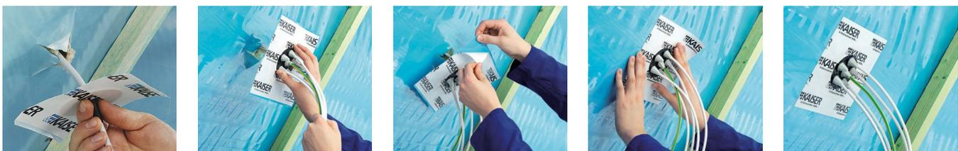
Bild 35: Installationsabfolge und Arbeitsweise der Knickschutztülle von Luftdichtungsmanschetten
